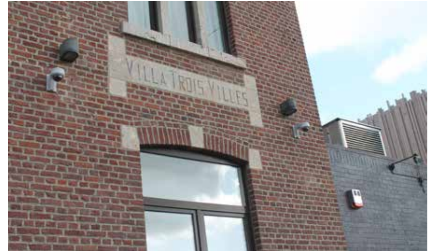
Chaque site est sécurisé par une combinaison de vidéosurveillance, de systèmes d'alarme, anti-incendie et/ou de contrôle d'accès adaptés aux besoins du bâtiment.
