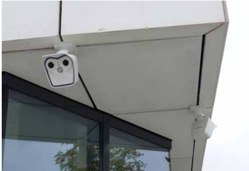
Er werden circa 35 MOBOTIX-camera's geïnstalleerd: M15's met dag- en nachtlezen om de directe buitenomgeving te observeren en i25/p25's in belangrijke binnenruimtes.
