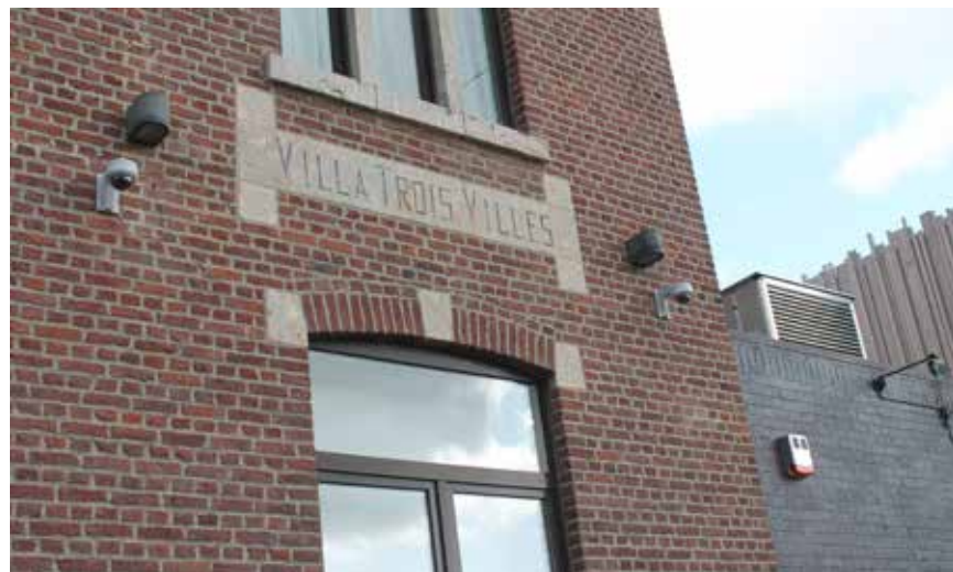
Op elke locatie komt er een combinatie van camerabewaking, alarm, brandveiligheid en/ of toegangscontrole, aangepast aan de noden van het gebouw.
